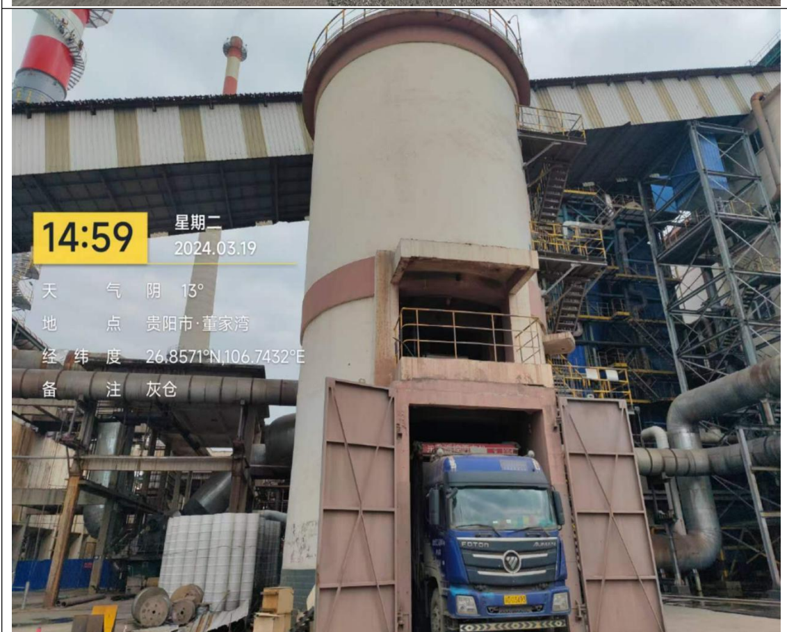
图 4.8 脱硫石膏仓及灰仓
