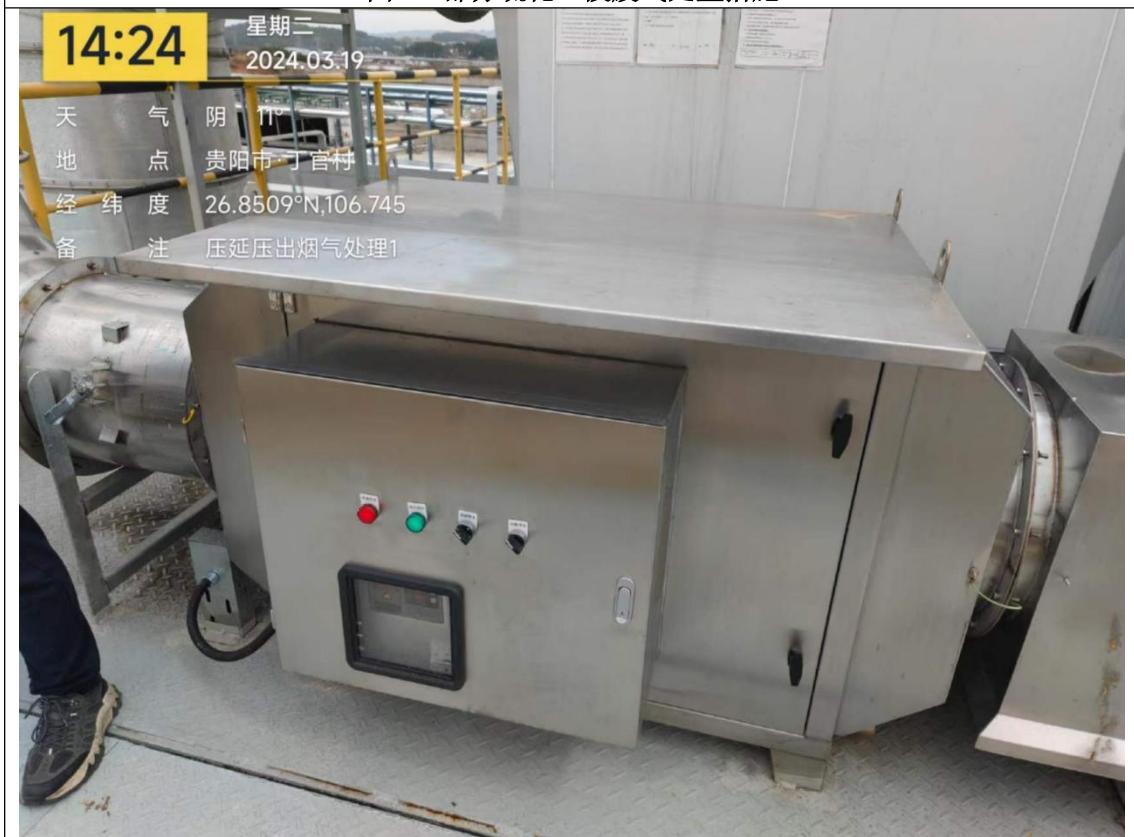
图4.3 部分硫化工段废气处置措施
