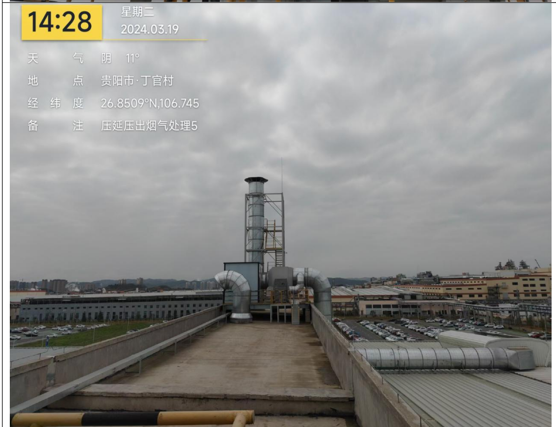
图4.4 部分压延工段废气处置措施
