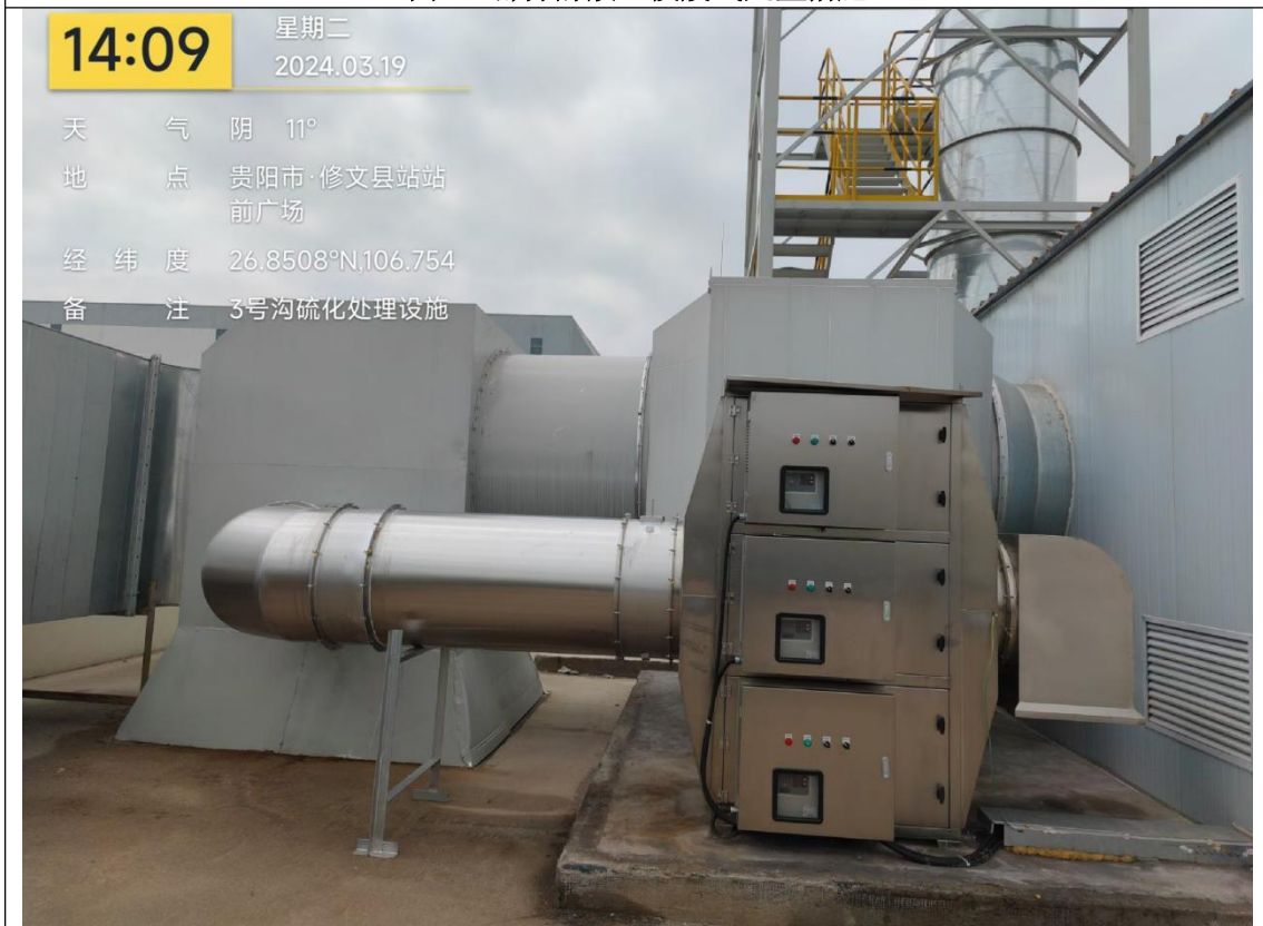
图4.2 部分炼胶工段废气处置措施
